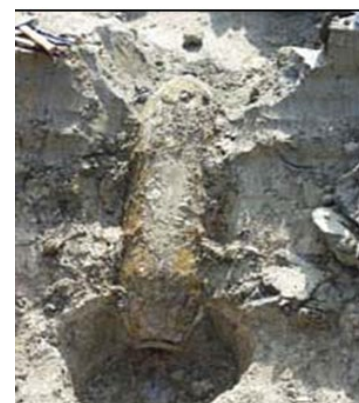
Abbildung 1 Fliegerbombe, ange- troffen bei Bauar- beiten in der Nähe einer Tankstelle
