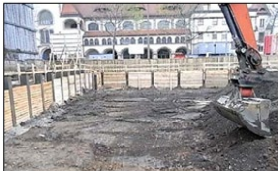
Abbildung 4 Schichtenweiser Abtrag, verpflichtend bei baubegleitender KMR
