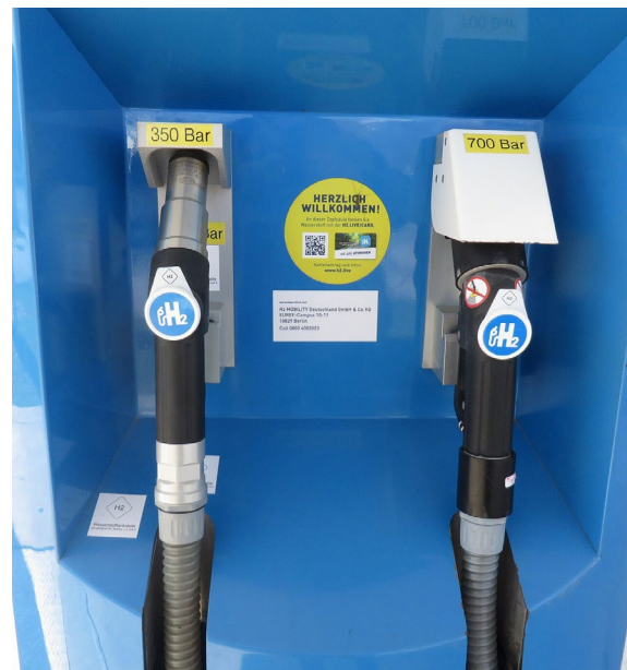
Beispielfoto einer Wasserstofftankstelle (Air Liquide) für PKW in Offenbach (Quelle: Wikipedia, Foto von L. Willms)
