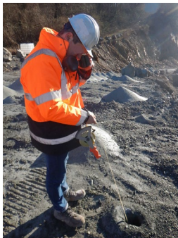
Überprüfung Richtung und Neigung eines Bohrloches inkl. Blick in das Bohrloch (Quelle: RP Darmstadt)
