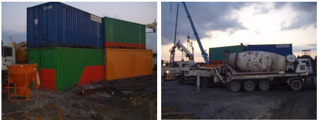
Abbildung 3. Provisorische mobile Abschirmwand aus Seecontainern für eine dahinter angeordnete Betonpumpe.
