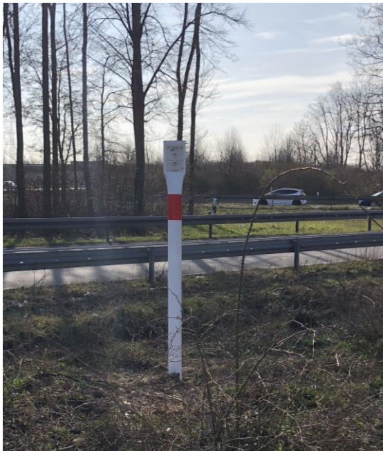
Abbildung 14: Schilderpfahl zur Markierung der Leitungstrasse
