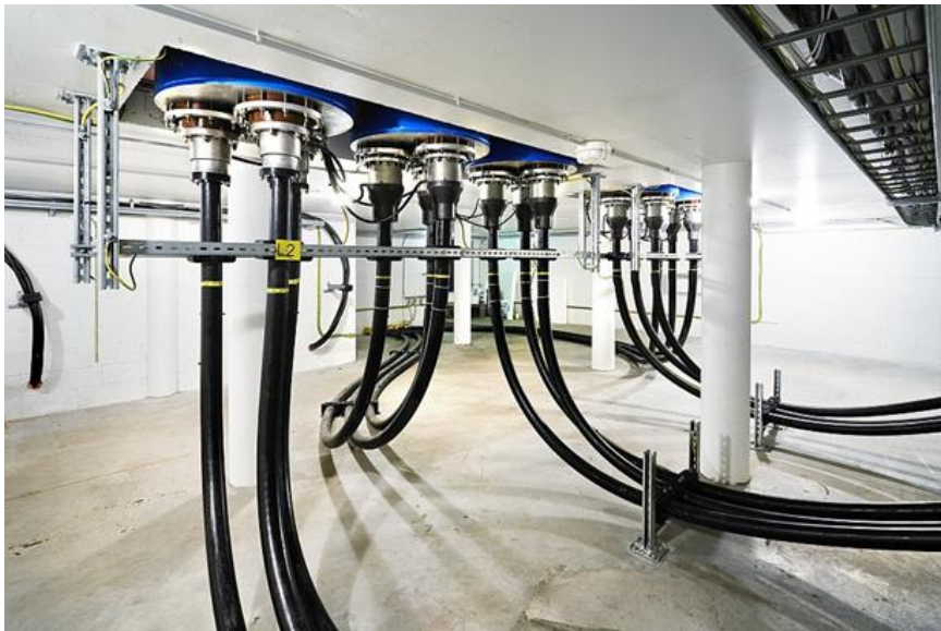
Abbildung 10: Kabelendverschluss mittels GIS-Steckern direkt an eine gasisolierte Schaltanlage (Beispiel)
