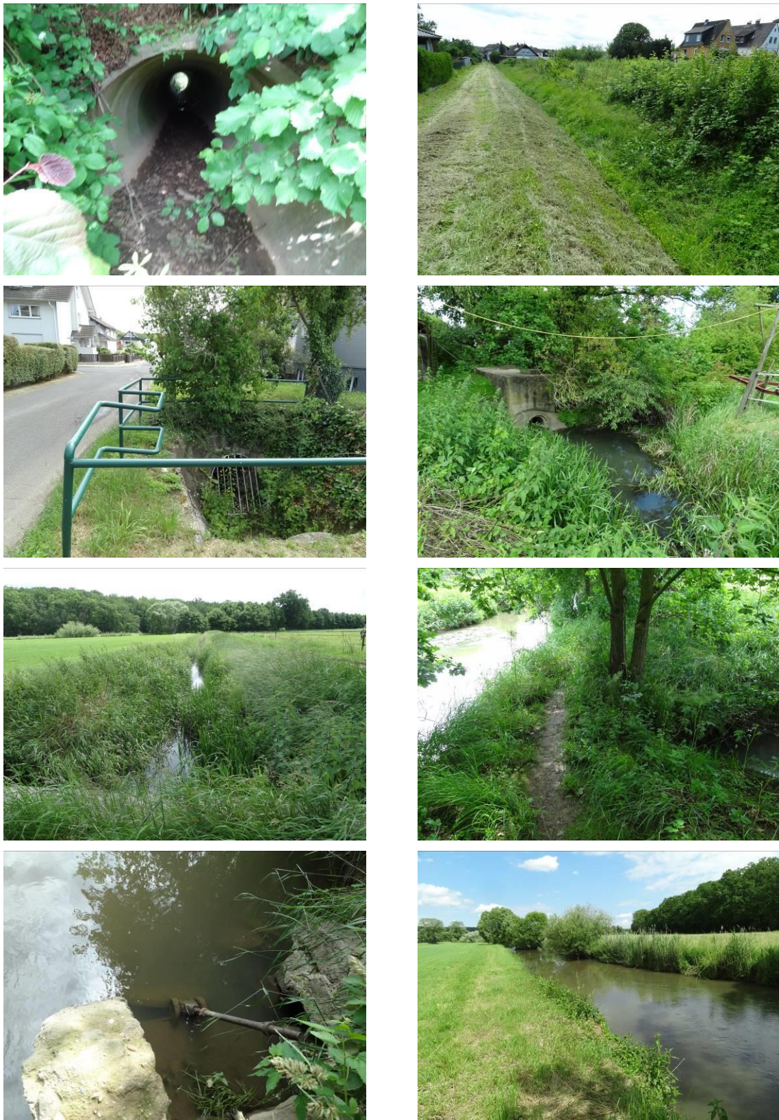
Abbildung 3-4: Fotos Vorfluter 1: Durchquerung Straßenwall nach B521– offener Graben – Beginn Verrohrung – Ende Verrohrung – Offener Graben Richtung Nidder – Durchquerung Uferdamm – Einmündung mit Rückschlagklappe – Nidder (von links oben nach rechts unten)
