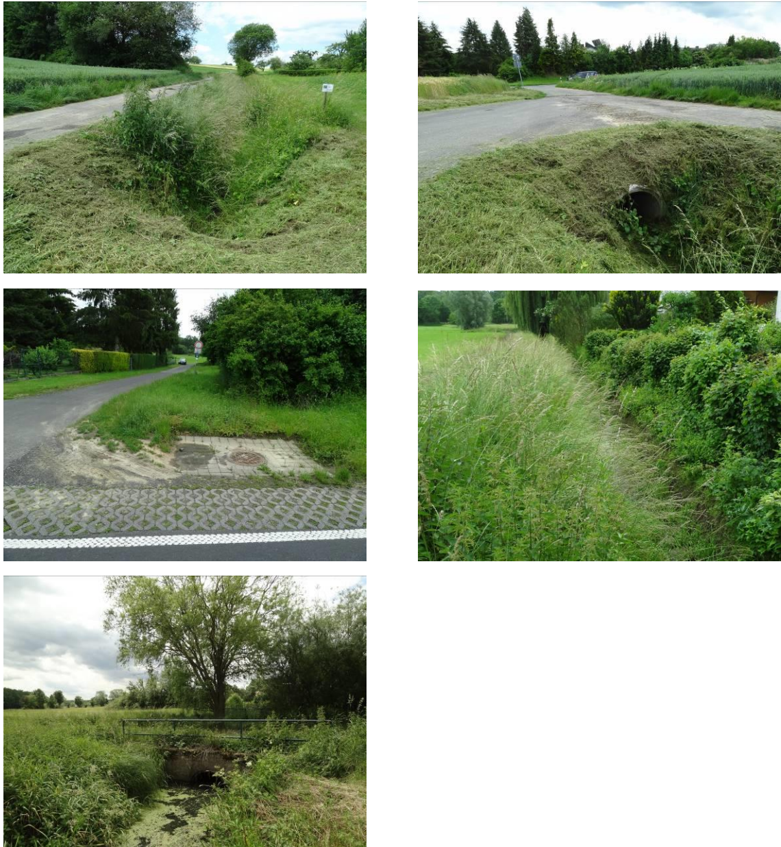
Abbildung 3-5: Fotos Vorfluter 2: Neuwiesengraben linksseitig der Straße an Landwirtschaftsweg vor B521 – Verrohrung vor Querung der Straße – unterirdische Zusammenführung mit Straßenablauf der B521 – wieder offener Graben – Stelle des Zusammenflusses mit Espengraben in Richtung Oberdorfgraben (von links oben nach rechts unten)
