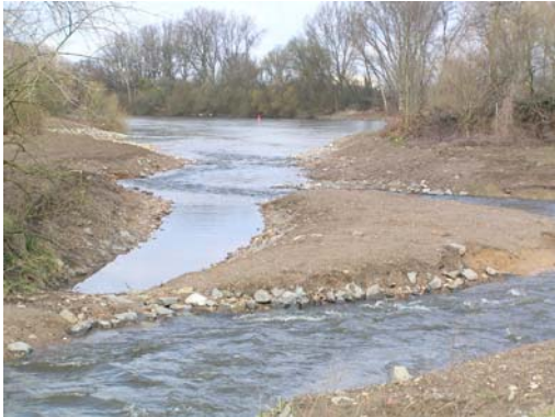
Abbildung 17 und 18 : Verbesserung der Fließstrukturen an der Rodaumündung mit Sukzession zur Entwicklung eines Gehölzsaumes
