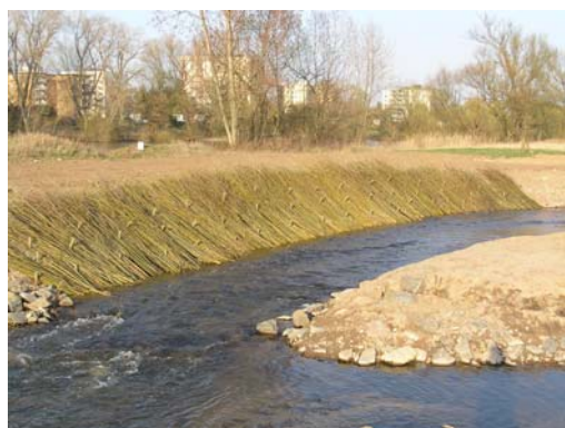
Abbildung 16: Böschungssicherung mit Weidenspreitlage bzw. Steinschüttung
